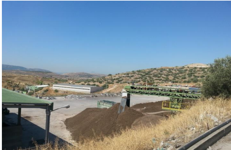
Εικόνα 8 Μονάδα Κομποστοποίησης και Ωρίμανσης ΕΜΑΚ Άνω Λιοσίων
