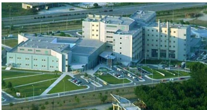
Κτιριακό Συγκρότημα Γενικού Νοσοκομείου Σερρών
