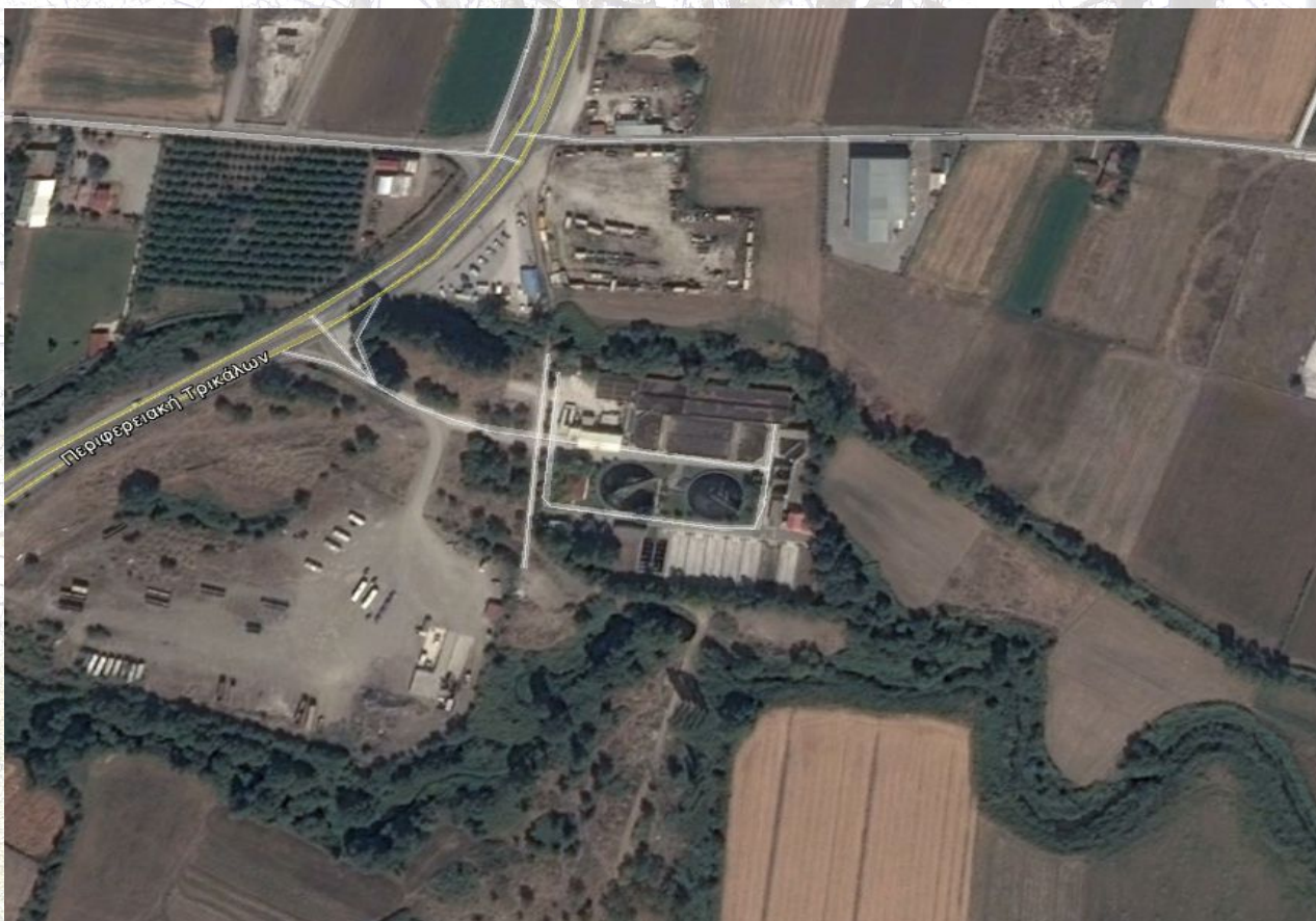
Εικόνα 1.2.11 Βιολογικός Καθαρισμός της πόλης των Τρικάλων
