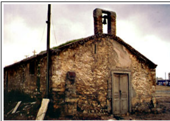
Το εκκλησάκι του Αγ. Γεωργίου (16ος αιώνας). Σήμερα βρίσκεται στην πλατεία δίπλα στον κτήριο του ΟΠΑΠ.
